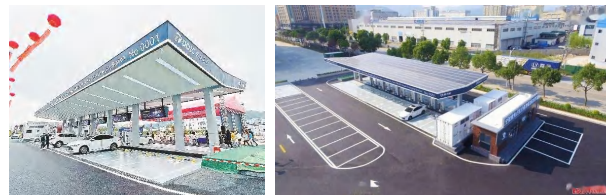
图 3.1-7 宁德锂电小镇光储充检智能超充站
