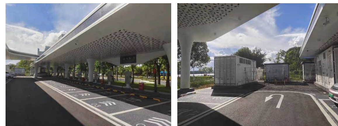
图 3.1-8 福州马尾江滨大道光储充检智能超充站
