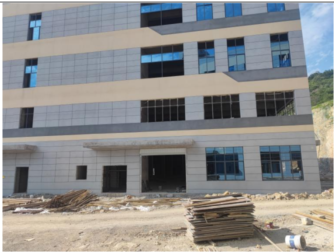
厂房现状（外部）
